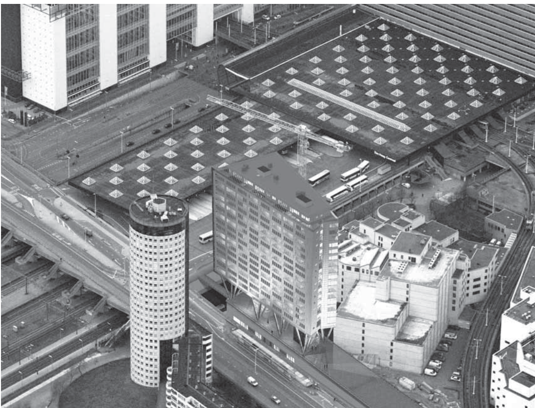
La Fenêtre project, The Hague
