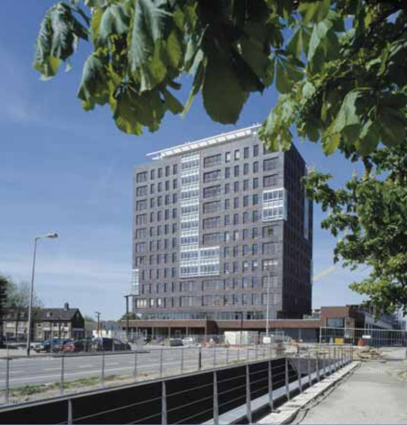
Twentectoren, Enschede/A12 Architecten
